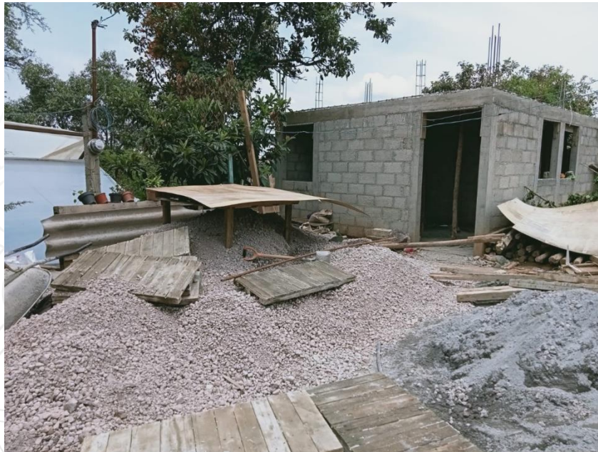
IMAGEN 1.1 TRABAJOS DE CONSTRUCCIÓN DE LAS VIVIENDAS
