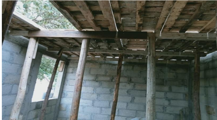
IMAGEN 1.0 TRABAJOS DE CONSTRUCCIÓN DE LAS VIVIENDAS
